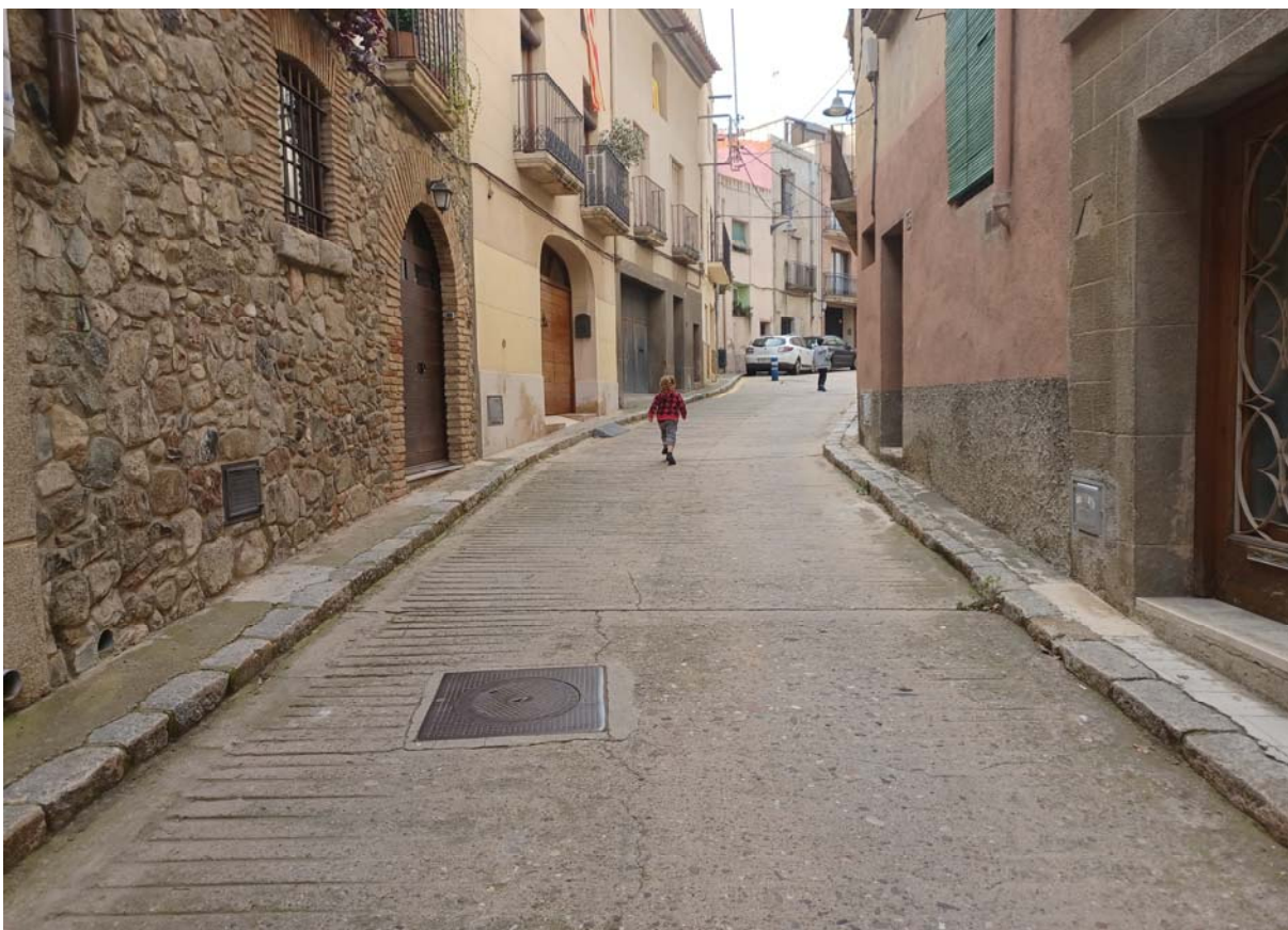
Estat actual del carrer de Baix fins a meitat del tram
